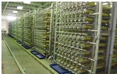
海水淡水化センター(沖縄県)膜処理装置
